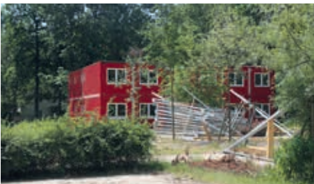
Abbau der Wohncontainer auf Baufeld B
