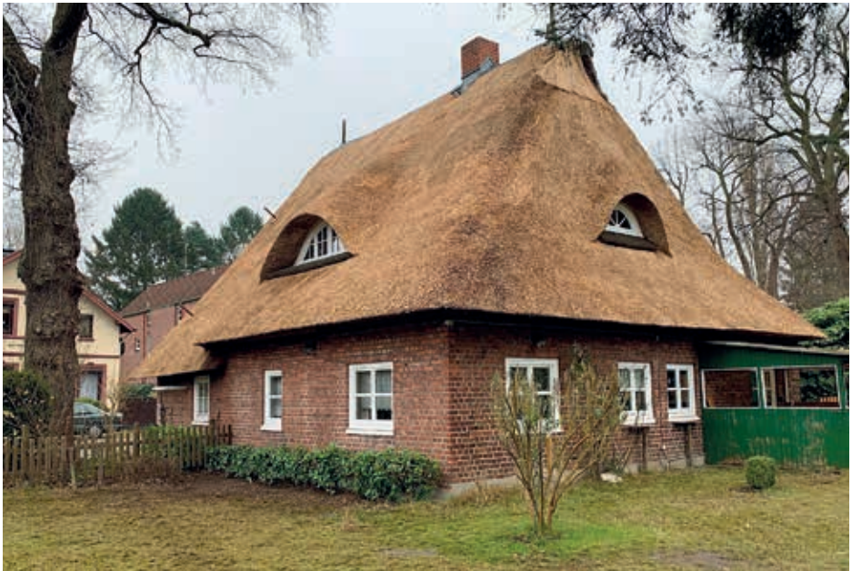
Neues Reetdach für das Haus Langelohstraße 145
