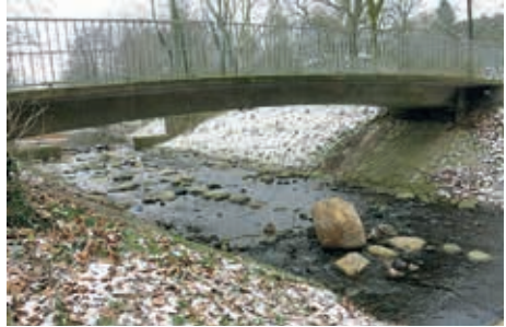
Bild 2: Fußgängerbrücke über der Pulverhofsohlgleite (Foto: Jörg Meyer)
