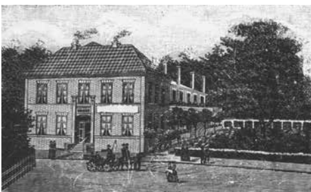
Bild 1. Blick auf die Westfront des Restaurants von der jetzigen Hasselmannstraße.
